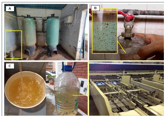
Figura 3. Resultados cualitativos. A) Falta de equipos y filtros en el sistema de tratamiento; B) Sólidos en suspensión; C) Agua utilizada para el mantenimiento y consumo/producto terminado. D) Clasificadora. Fuente: Empresa / Fotos de inspección.
