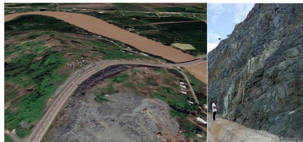
Figura 2. Estaciones geomecánicas en el cerro San José, Daule, norte de Guayaquil. Las estaciones T4 y T5 son localizadas en la base del corte de talud.
