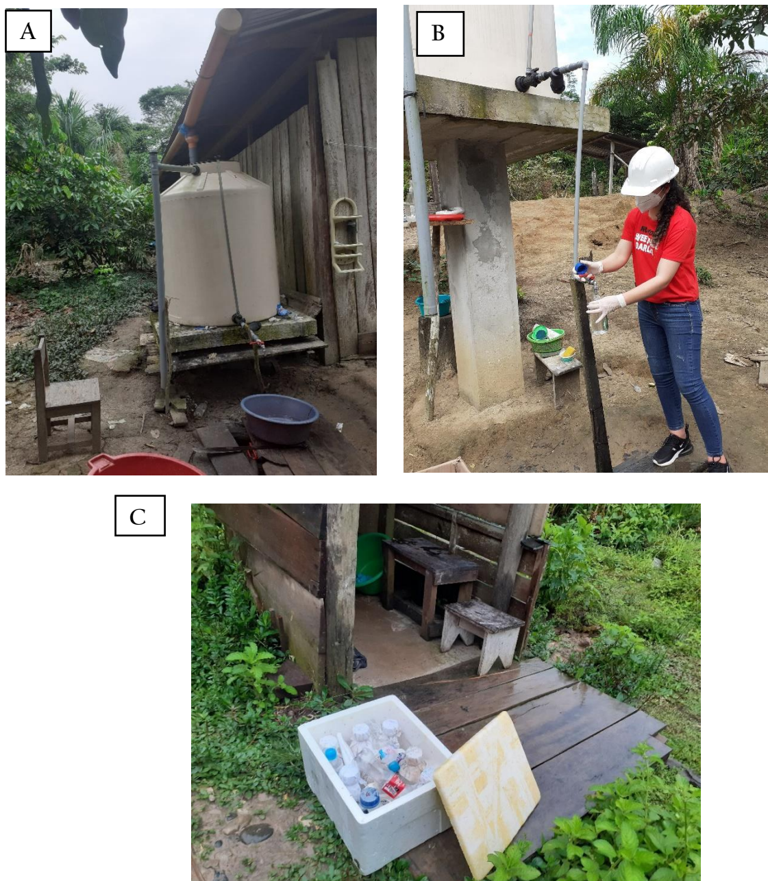
Figura A=Prototipo de captación y reutilización de agua de lluvia; Figura B=Recolección de muestras de agua; Figura C=Caja de tecnopor acondicionada con hielo seco para el traslado de muestras.
