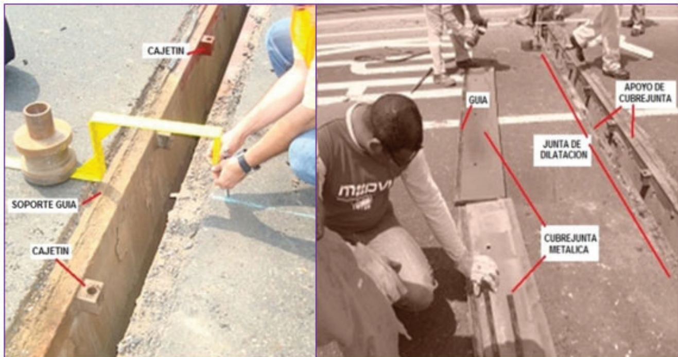
Figura 5. Cubrejunta secundario del Puente General Rafael Urdaneta.
