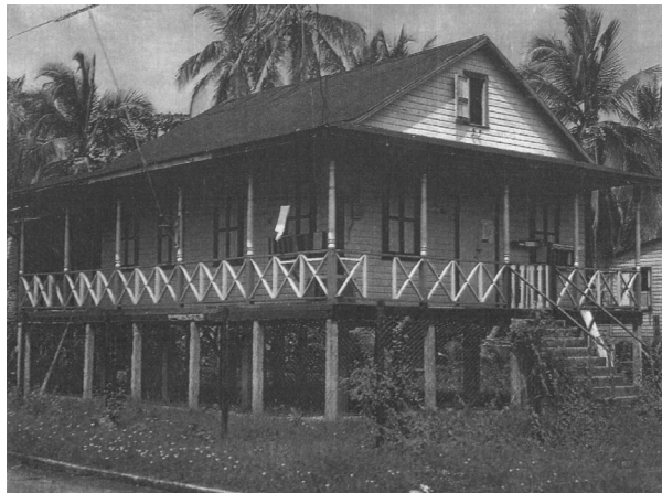
Figura 16 Casa sobre pilotes en Puerto Limón, Costa Rica. Fuente: Gutiérrez, 1981.
