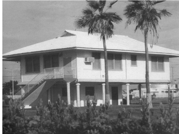
Figura 3 Casa de campo Zulima, (Creole) Lagunillas. Fuente: Romero, 1997
