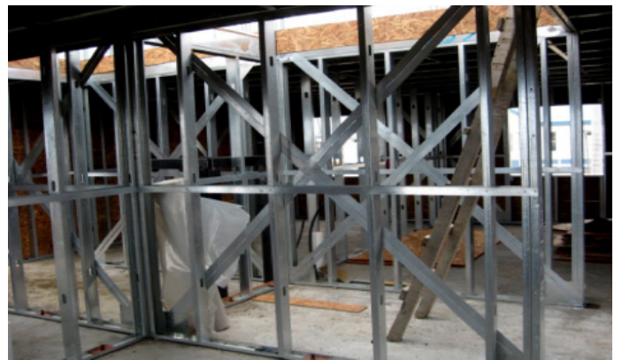
Figura 10. Arriostramiento con cruces de San Andrés
