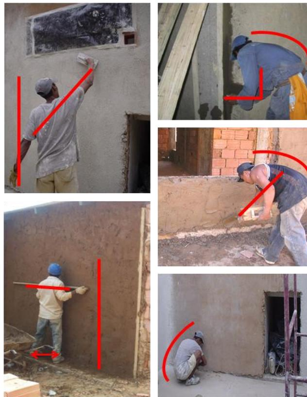
Figura 4. Movimientos y Posturas Comunes en la construcción de revestimientos
