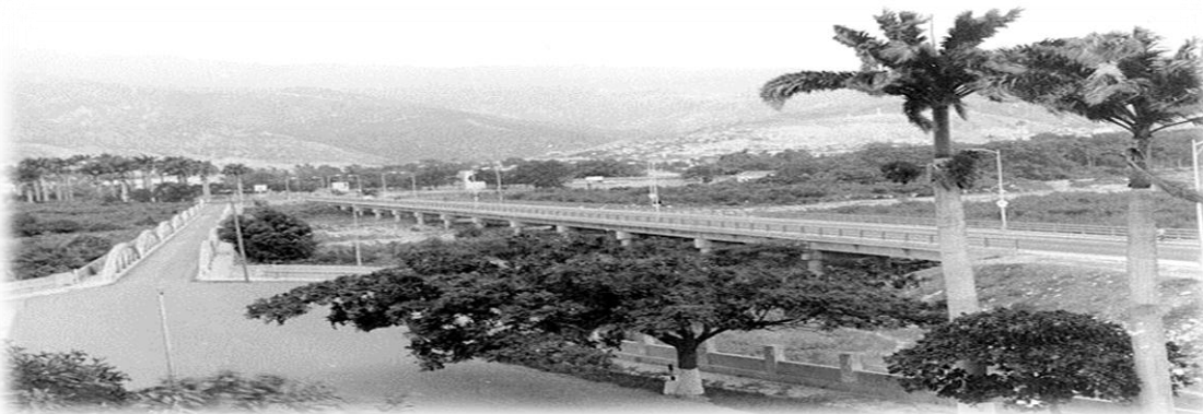
Ilustración 2. Antiguo Puente sobre el río Pamplonita–San Luis-Cúcuta
