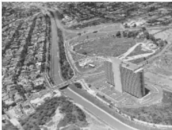
Figura 6. Edificio Shell La Estancia. Diego Carbonell. Urbanización Chuao, Caracas 1958-1959
