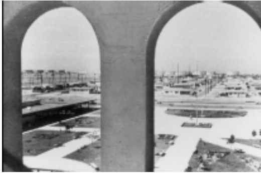
Figura 9. Campamento de Judibana, estado Falcón (1958)
