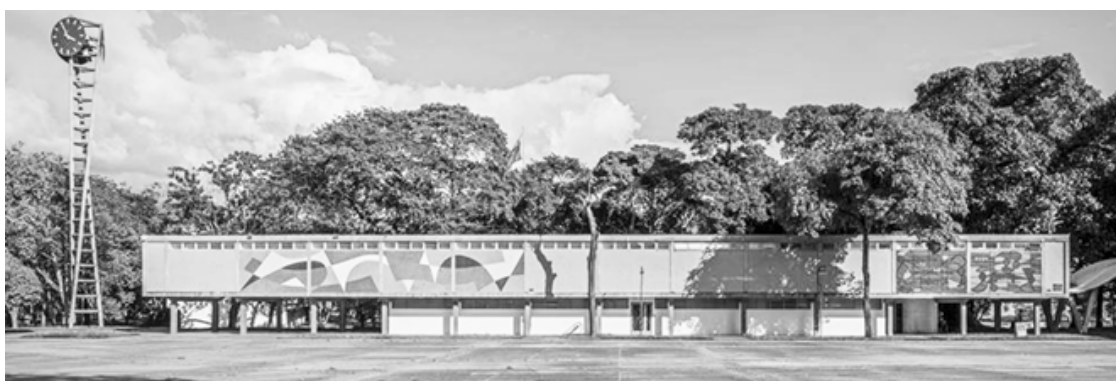
Figura 3. Antigua sede del Museo de Biología de la Universidad Central de Venezuela. Arriba: edificio en construcción en 1952. Abajo: fachada principal del edificio ya construido, donde se aprecian las obras de los artistas plásticos venezolanos Armando Barrios (1953, a la izquierda) y Oswaldo Vigas (1954, a la derecha).
